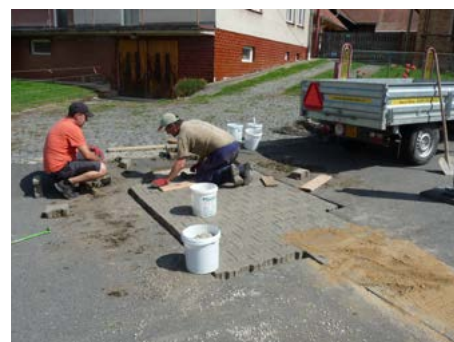
Oprava překopu cesty /
