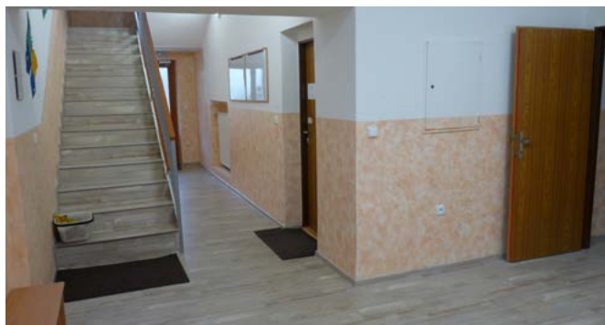
Oprava prostor obecního úřadu- po
