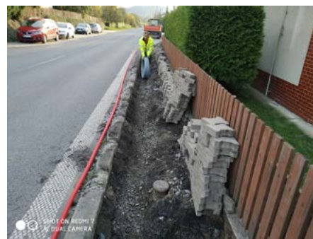
Oprava veřejného osvětlení /
