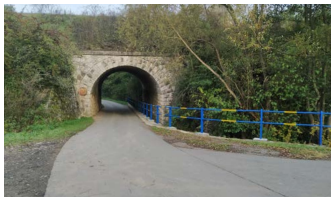
Oprava zábradlí v Sedlčném /
