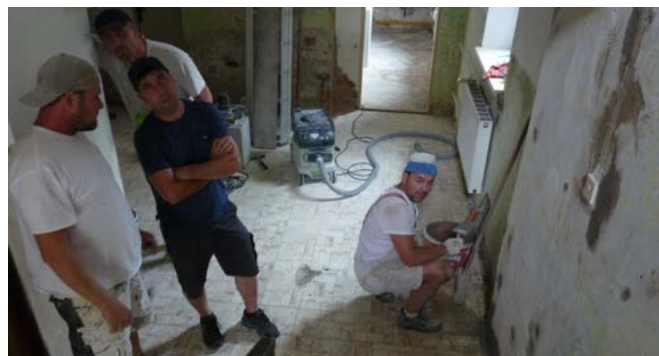
Oprava prostor obecního úřadu- před
