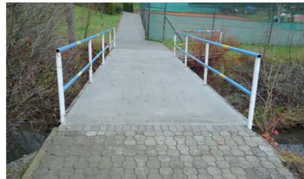
Oprava mostku na chodníku za zbrojnicí
