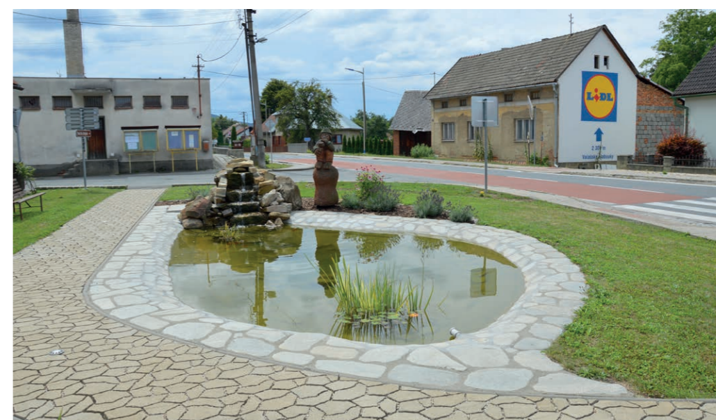
Oprava okamenování jezírka
