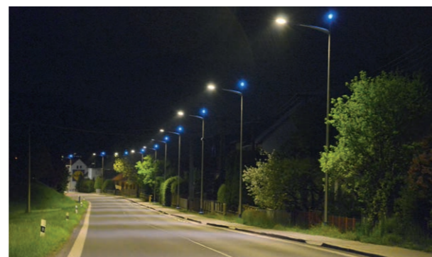
Rekonstrukce veřejného osvětlení u hl. silnice
