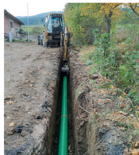
Prodloužení kanalizace pod Stráží
