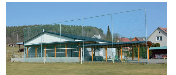
Rekonstrukce kabin FK Poteč
