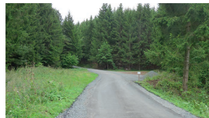
Oprava lesní cesty svážnice
