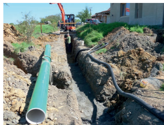
Prodloužení kanalizace za Vlastů
